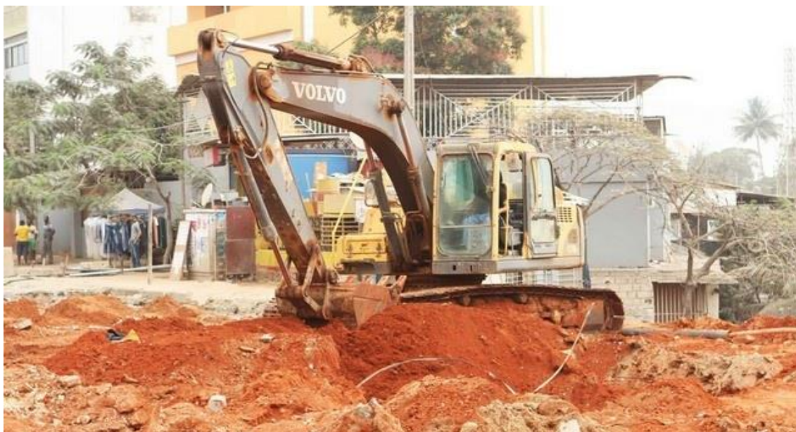
ESCAVAÇÃO PARA CRIAÇÃO DE VIADUTO NO SAMBIZANGA
