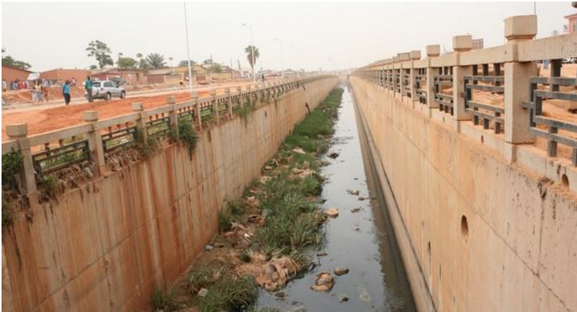
VALA DE DRENAGEM
