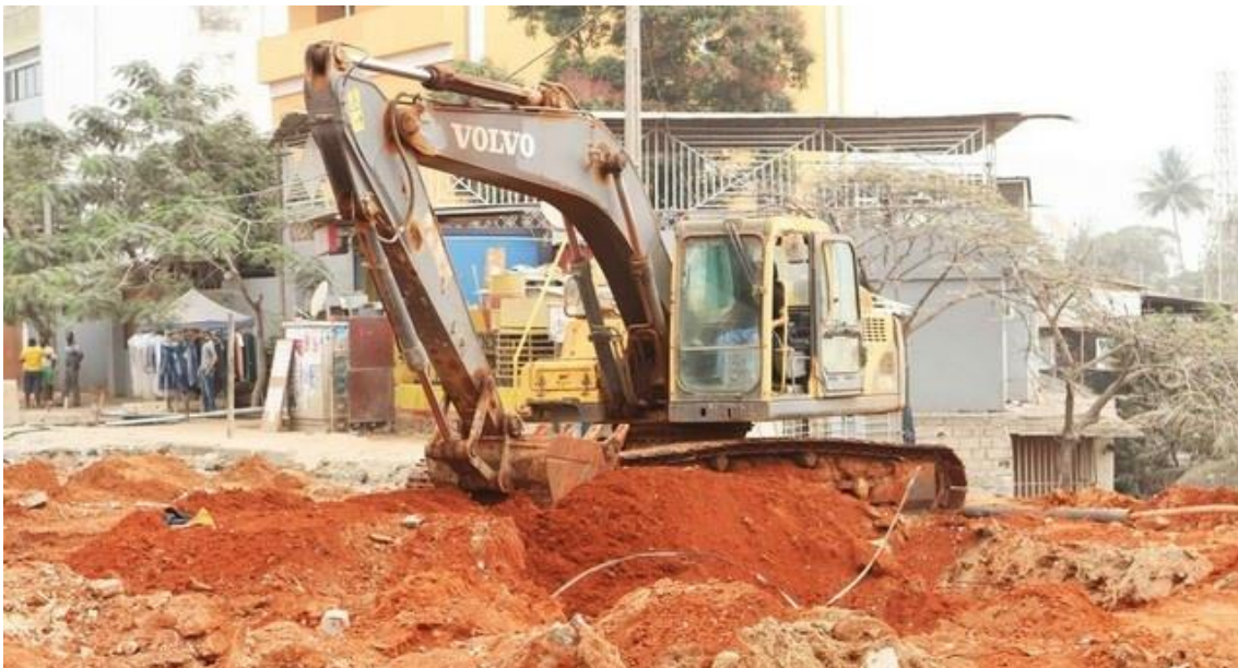
TERRAPLANAGEM NUM DOS TROÇOS RODOVIÁRIOS (ARQUIVO)
