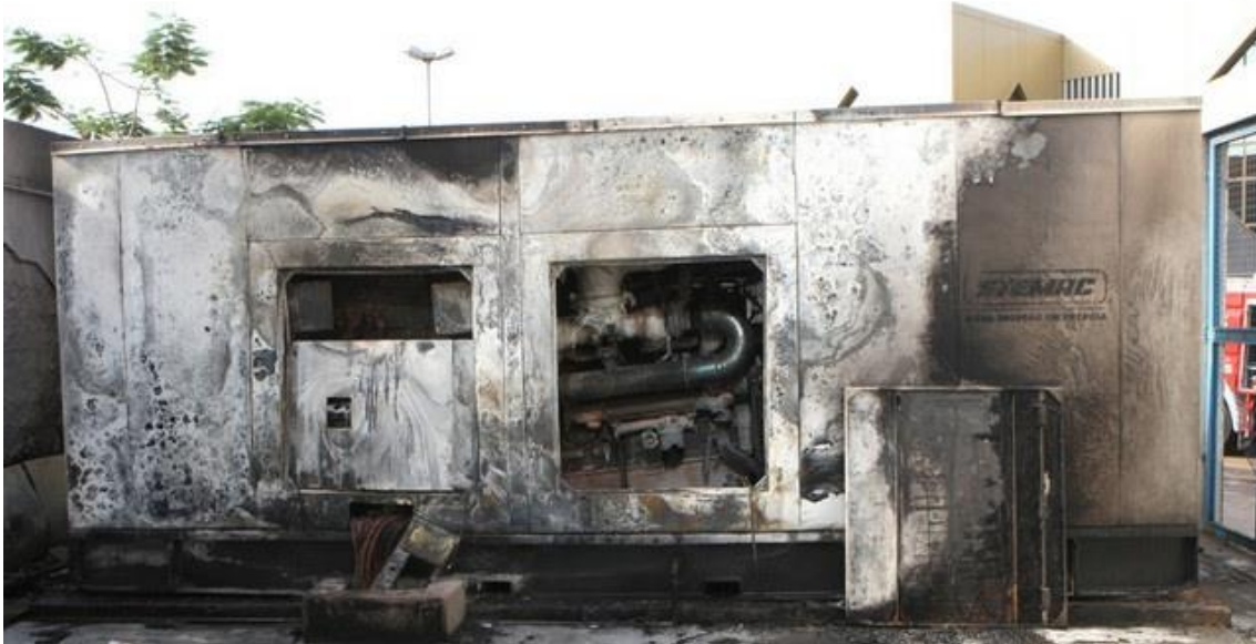
ESTADO DE UM ARMAZÉM DEPOIS DO INCÊNDIO
